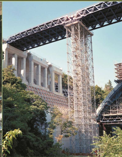
上 紀北東道路 高野口IC工用仮設栈橋 (和歌山県 橋本市 高野口) 工用仮設道路の規模は 橋長 162m、高さは杭頭部より16.1m、幅員6m、縦断勾配3.9% 元請様に於いて、H鋼材との比較検討に於いて、工期の短縮、作業の安全性、経済性、そして後のスクラップ発生等々を総合的に削減することが出来ると判断されて、ご採用頂きました。 下 神戸淡路鳴門自動車道 茶間川本線橋仮橋 (兵庫県 淡路市 岩屋町茶間) 工用仮設道路の規模は 橋長 180m、高さ 40m 仮設中にほぼ直下を震源とする「阪神淡路大地震」が発生、両側のアハットとの間が30cm程接近しましたが、無事に持ち堪える事が出来ました。更に安全確認後、特に補修も無く工事はすぐに再開されました。
