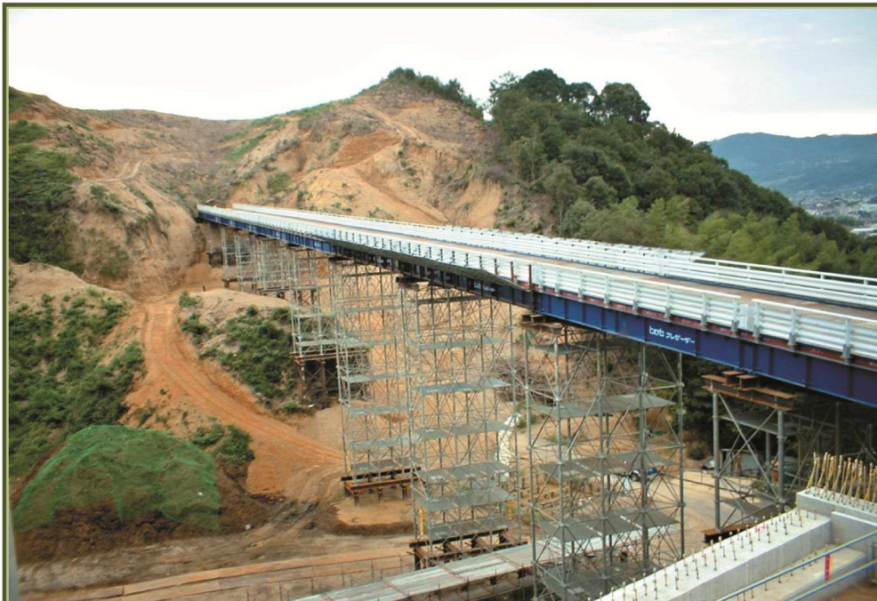
上 紀北東道路 高野口IC工用仮設栈橋 (和歌山県 橋本市 高野口) 工用仮設道路の規模は 橋長 162m、高さは杭頭部より16.1m、幅員6m、縦断勾配3.9% 元請様に於いて、H鋼材との比較検討に於いて、工期の短縮、作業の安全性、経済性、そして後のスクラップ発生等々を総合的に削減することが出来ると判断されて、ご採用頂きました。 下 神戸淡路鳴門自動車道 茶間川本線橋仮橋 (兵庫県 淡路市 岩屋町茶間) 工用仮設道路の規模は 橋長 180m、高さ 40m 仮設中にほぼ直下を震源とする「阪神淡路大地震」が発生、両側のアハットとの間が30cm程接近しましたが、無事に持ち堪える事が出来ました。更に安全確認後、特に補修も無く工事はすぐに再開されました。
