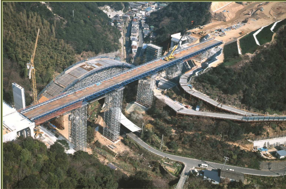
上 紀北東道路 高野口IC工用仮設栈橋 (和歌山県 橋本市 高野口) 工用仮設道路の規模は 橋長 162m、高さは杭頭部より16.1m、幅員6m、縦断勾配3.9% 元請様に於いて、H鋼材との比較検討に於いて、工期の短縮、作業の安全性、経済性、そして後のスクラップ発生等々を総合的に削減することが出来ると判断されて、ご採用頂きました。 下 神戸淡路鳴門自動車道 茶間川本線橋仮橋 (兵庫県 淡路市 岩屋町茶間) 工用仮設道路の規模は 橋長 180m、高さ 40m 仮設中にほぼ直下を震源とする「阪神淡路大地震」が発生、両側のアハットとの間が30cm程接近しましたが、無事に持ち堪える事が出来ました。更に安全確認後、特に補修も無く工事はすぐに再開されました。
