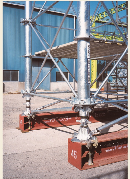
● スティフナー・ジャッキにより敷桁格点部の補強
